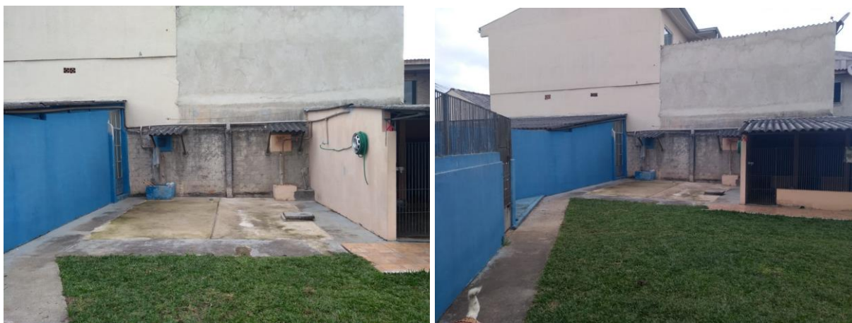
Imagem 15 – Rede de distribuição de água utilizada Fonte: Site Hotel Paradiso
